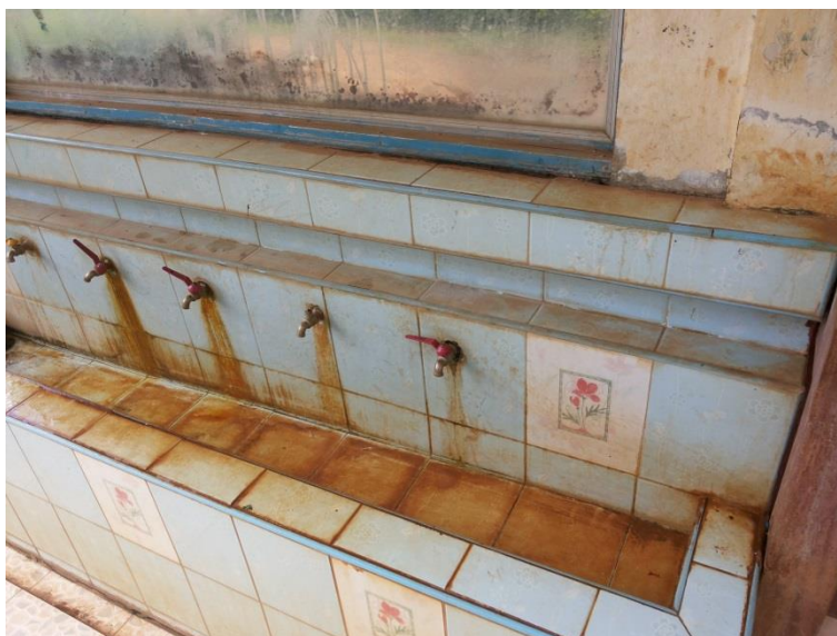
รูปที่ 4.4 น้ำประปาชุมชนมีลักษณะขุ่น เหลือง ไม่เหมาะแก่การบริโภคและใช้ในกิจกรรมสร้างเสริมลักษณะที่ดีในการแปรงฟัน
